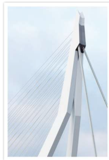
Rotterdam Erasmusbrug close-up 323
